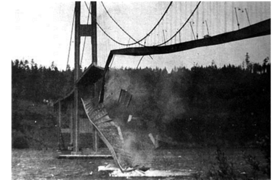
タコマ橋(1940) 渦流出&自励振動
