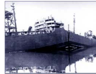
リバティー船(1942) 溶接不良&低温脆性破壊
